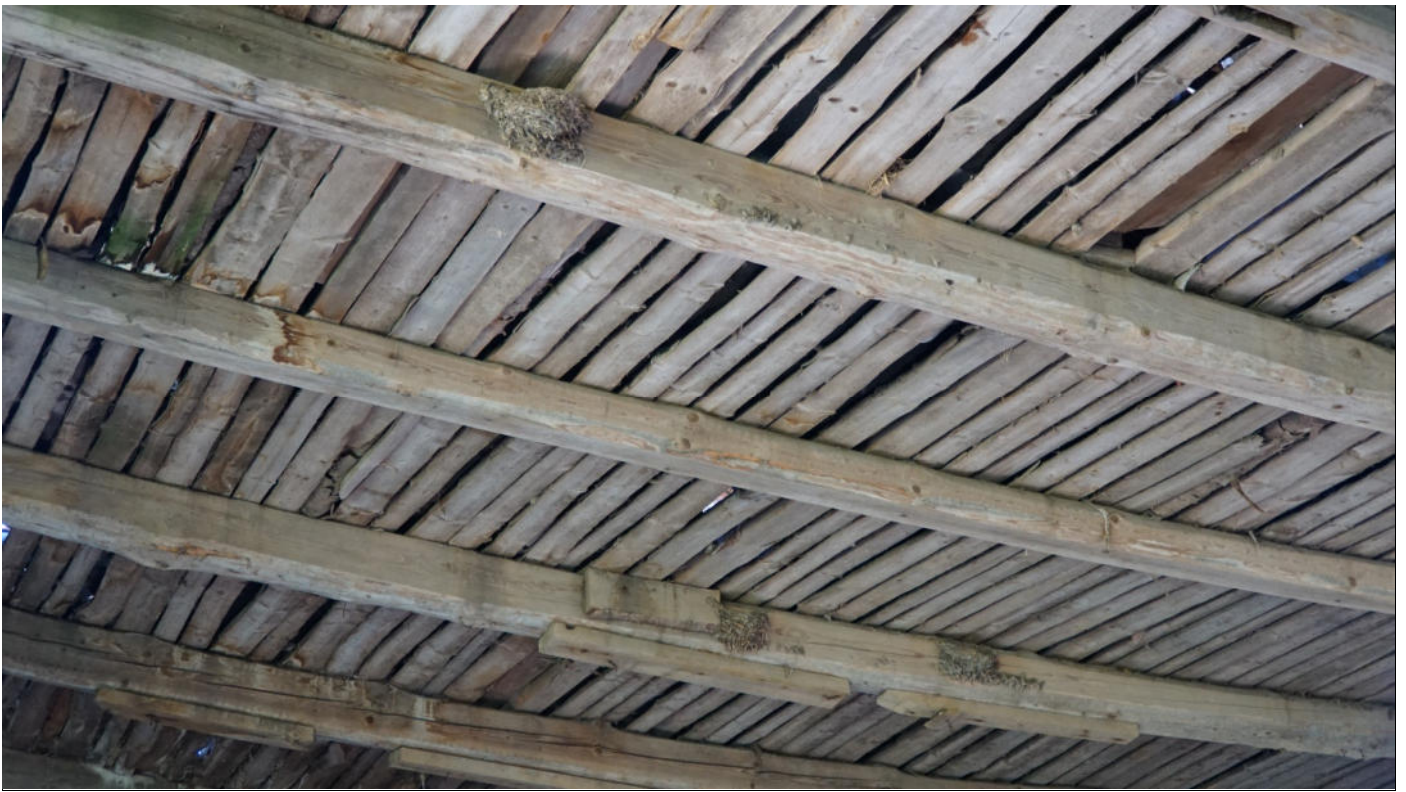
Sparren des südlichen Schleppdaches mit älteren Niststätten der Rauchschwalbe ( Hirundo rustica )
