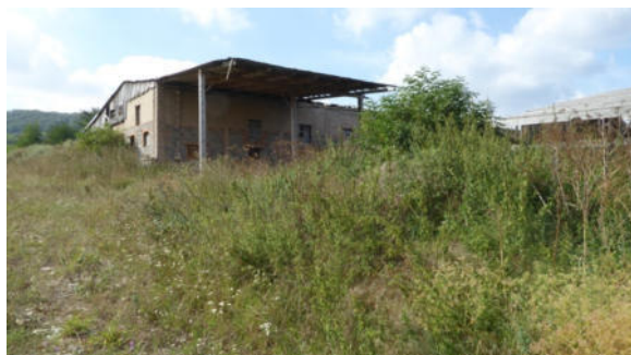
Abb. 6: Östlicher Bereich des UG im August
