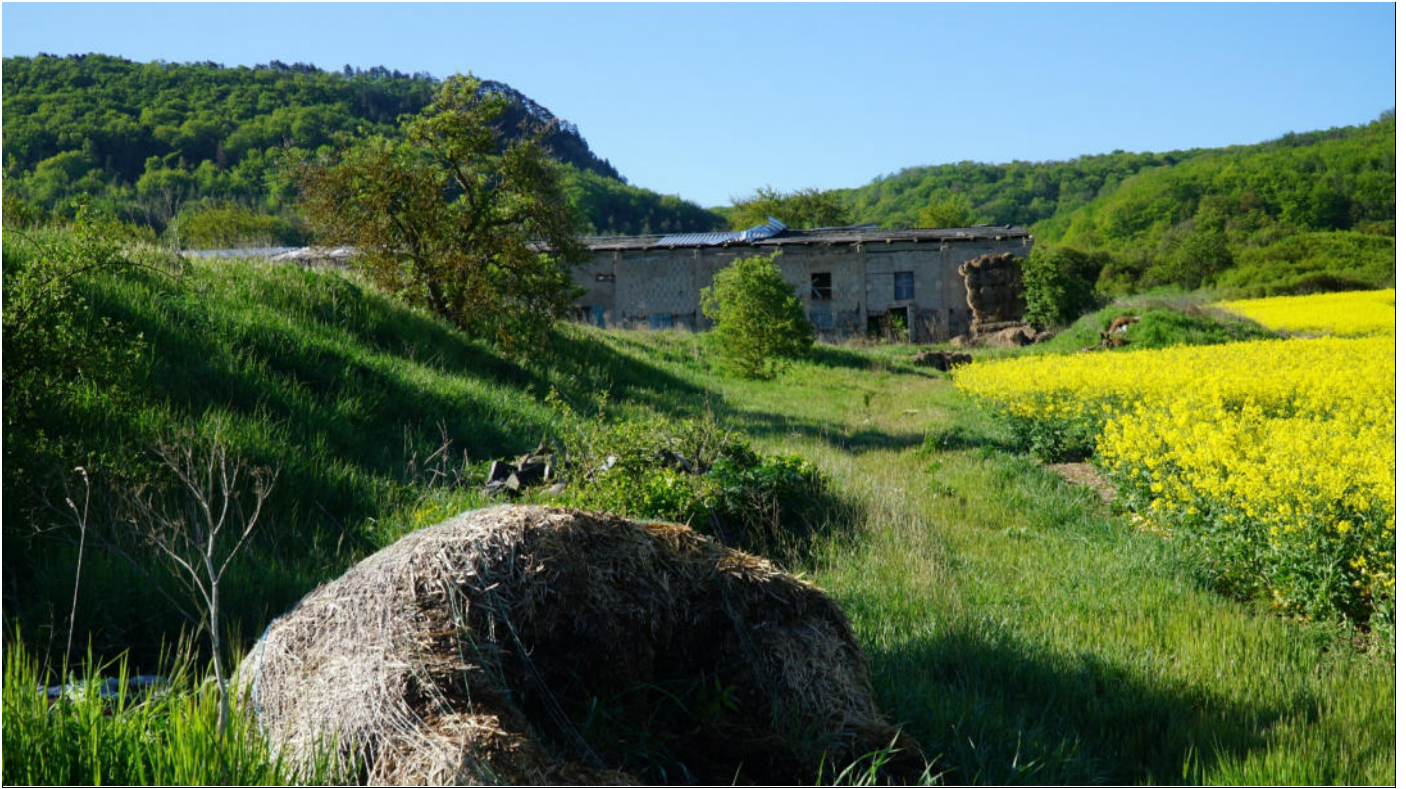
Nordwestbereich, Blick nach Süden
