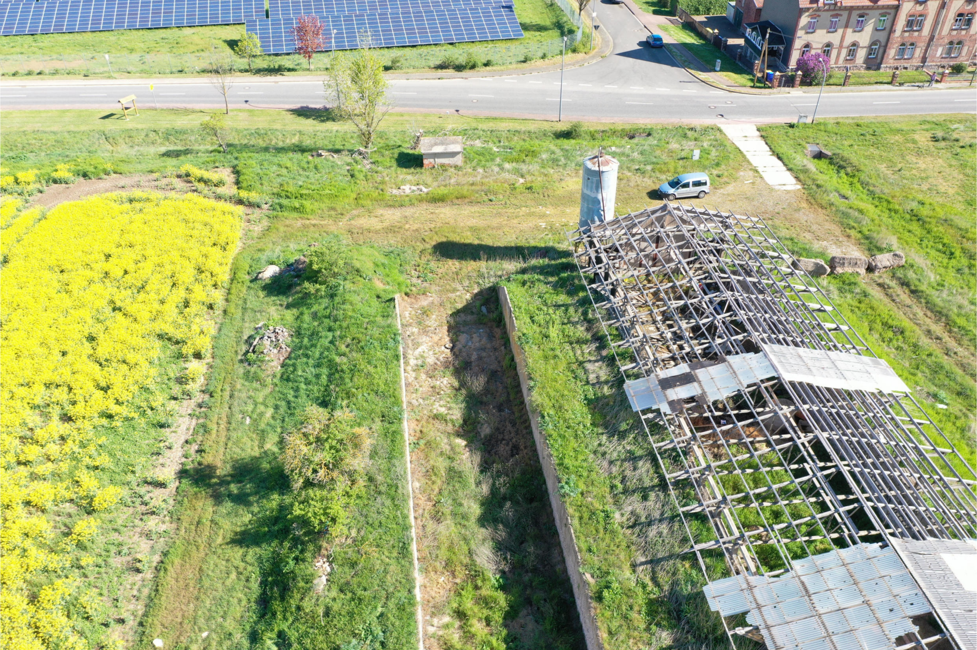
Nördliche Teilfläche, Blick nach Norden (Anfang Mai 2020)
