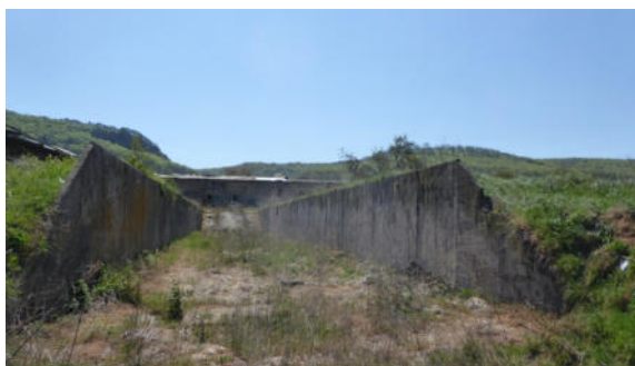
Abb. 3: versiegelte Fläche im Norden des UG
