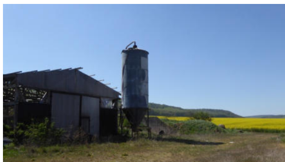
Abb. 2: Blick auf den Norden des UG
